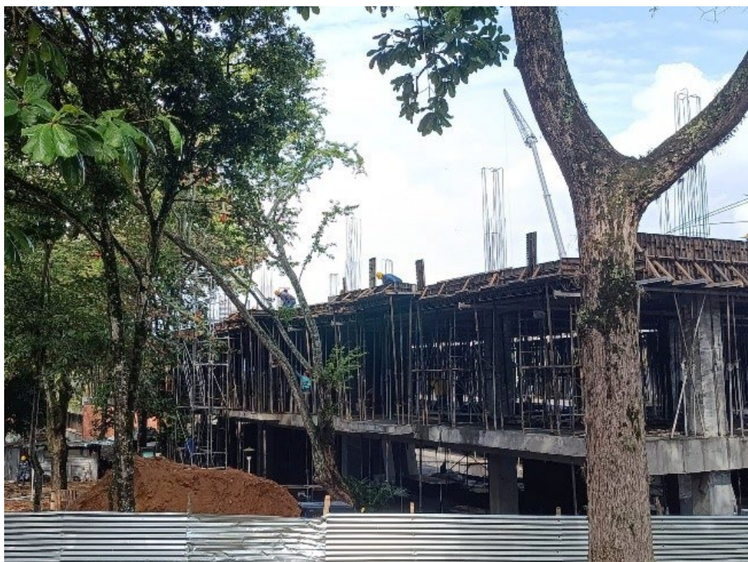
Construcción Bloque Administrativo UISALUD - Inversión: $ 1.659.878.054
