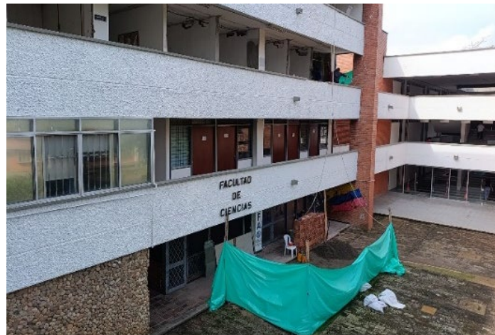
Remodelación Edificio de la Facultad de Ciencias - Inversión: $ 3.717.083.959
