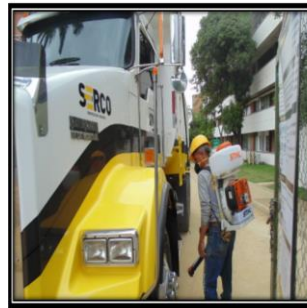
Ilustración 12: Fregación de volquetes doble troque al ingreso y salida diariamente.
